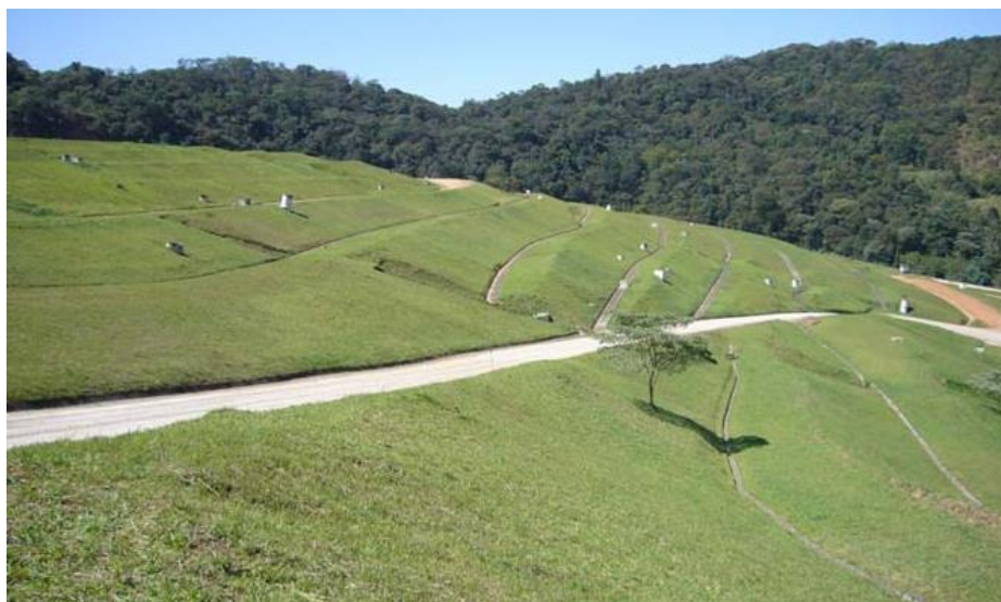
Figura 8: Vista do Aterro Vila Albertina, localizado no município de São Paulo Fonte: Loga, 2014
