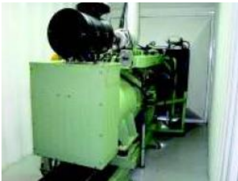
Figura 20 – Motor ciclo Otto adaptado a biogás.
